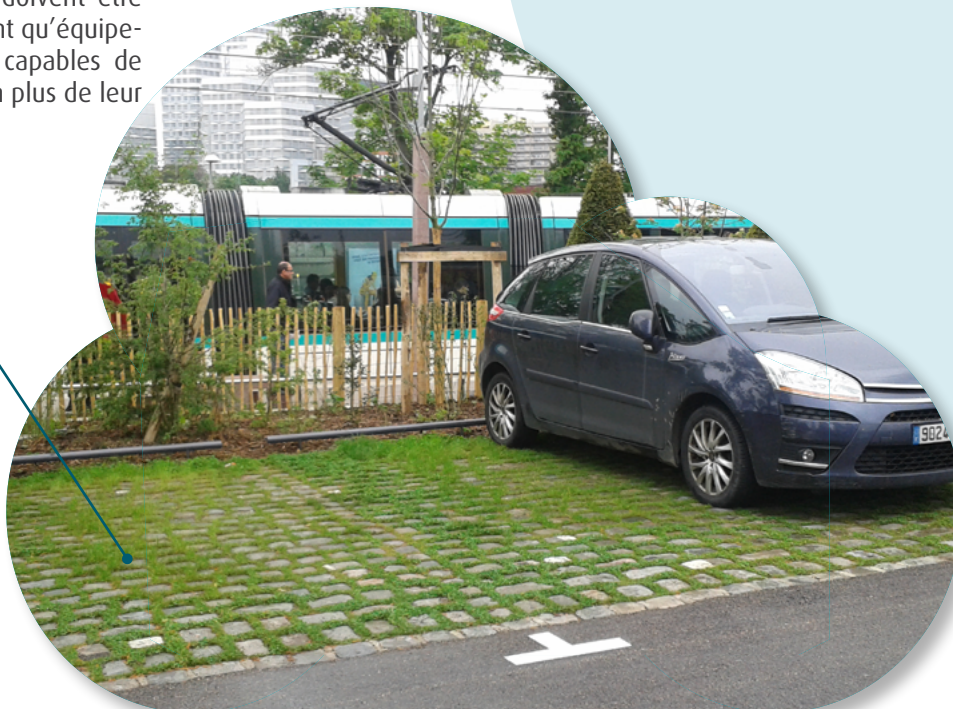
Parking infiltrant évitant l'imperméabilisation, Fresnes (DRIEE)
